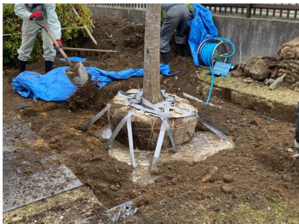
地下支柱施工状況
