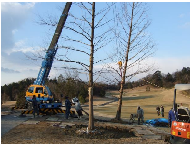
クレーンにて立て込み
