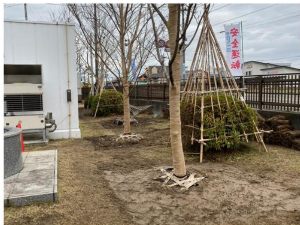
地下支柱施工状況
