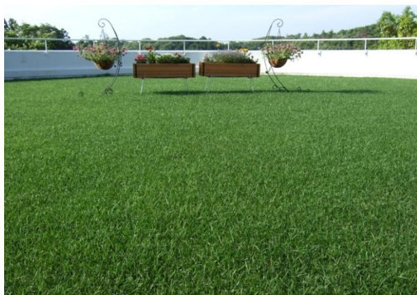
冬の施工で完成したケンタッキーブルーグラスの屋上緑化
