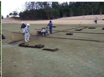
斜面に並行掘削
