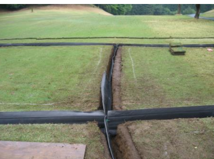
TPドレーン敷き設
