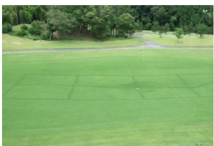
夏の TPドレーン施工区
