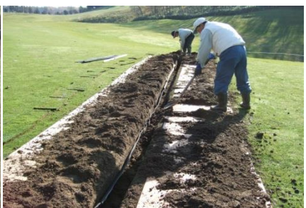
掘削土埋め戻し
